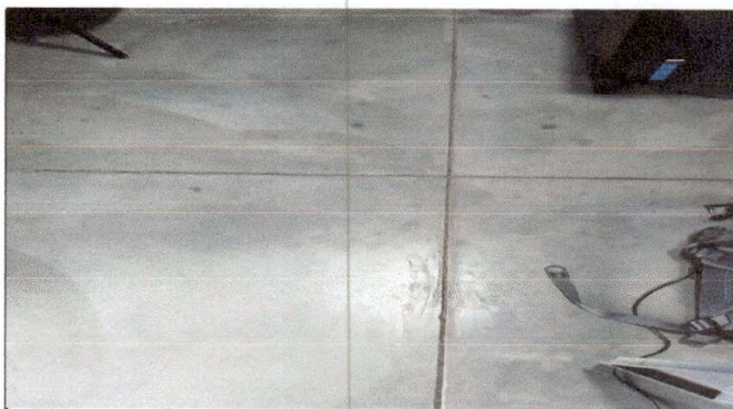
Foto MODULO 3, PISO, Sustitución de piso ceramico
