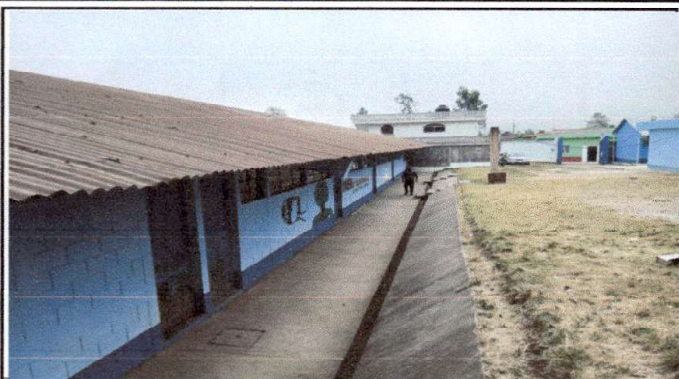
Foto1: MODULO 1, cubierta de Lamina sustitucion de lamina Troquelada Aluzinc Calibre 26, Canales y Bajadas de Agua, pintura en muros exteriores e interiores
